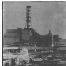
Zniszczony reaktor w Czernobylu: zły rok dla technologii
