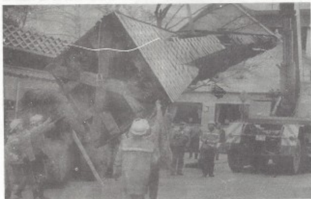
Zniszczona wieża kościoła w Wallmerode (RFN).
