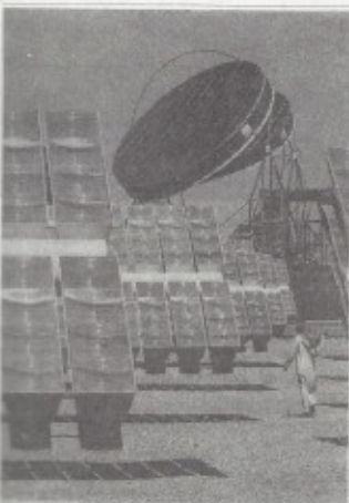
"Słoneczna" elektrownia w Arabii Saudyjskiej
