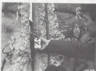
Dziury w murze: Droży łowcy pamiątek, zaprzestanie, prosimy, czynienia szkód na własności NRD. fot. Aleksandra Bessert
